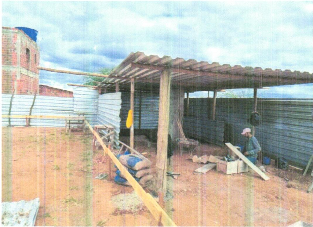
FOTO 06 - EXECUÇÃO DE DEPÓSITO EM CANTEIRO DE OBRA EM CHAPA DE MADEIRA COMPENSADA, NÃO INCLUSO MOBILIÁRIO. AF_04/2016
